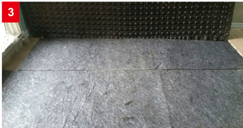
3. PS 흡음재 설치
